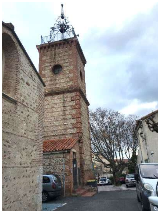
☞ Photographie : Eglise Saint-André et de la tour de l'Horloge
