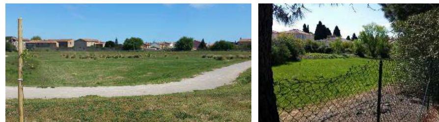
☞ Photographies : Bassins de rétention
