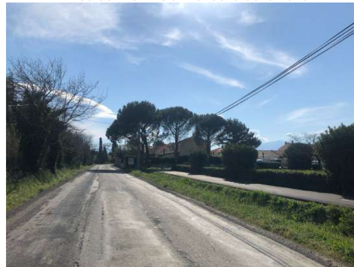
Entrée de ville – Vers Villeneuve-de-la-Raho
